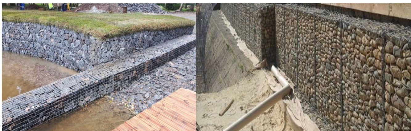
Рисунок 1 – Примеры габионных конструкций
