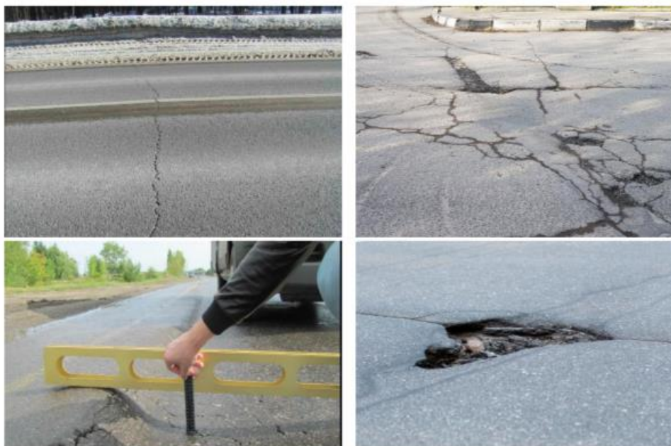
Рисунок 1 – определение дефектов на дорожном полотне
