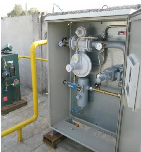
Рисунок 2- Испарительная установка для газгольдера
