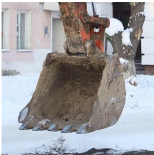
Рисунок 1 – Намерзший грунт на ковше экскаватора
